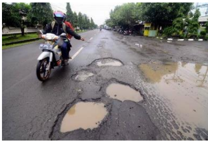
Jalan berlubang dan retak-retak
